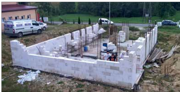
Budowa nowej remizy OSP Źródło: archiwum OSP Stańkowa
